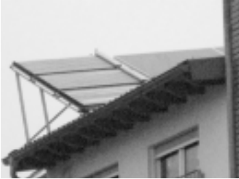
ソーラー発電機
