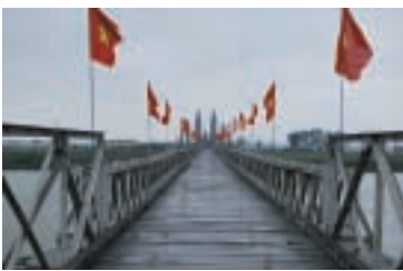
17度線のヒエンルン橋
