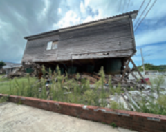
▲地震で隆起した海岸（上）、倒壊した家屋（下）
