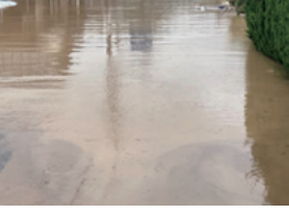
▲豪雨により冠水した道路
